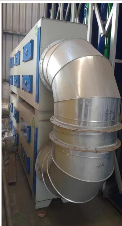
过滤棉装置+两级活性炭吸附装置+1 根 15m 高排气筒
