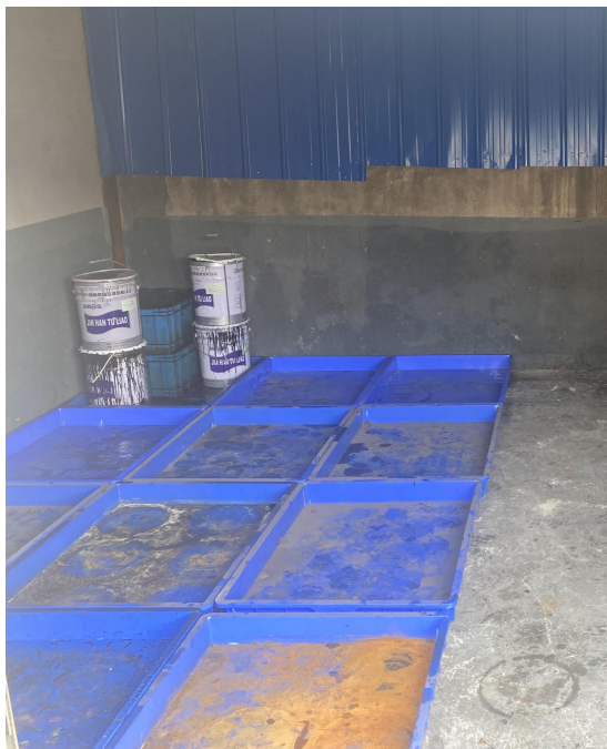
危废暂存间防渗漏托盘
