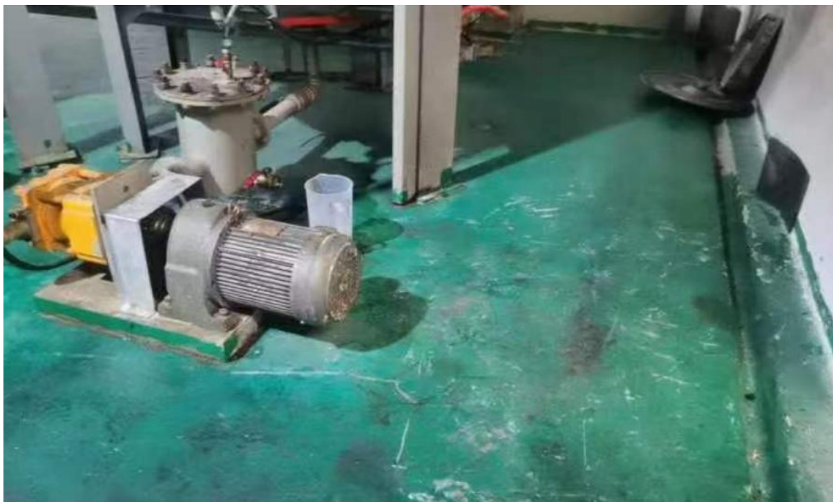
图 4.2-4 建设项目中转罐区
