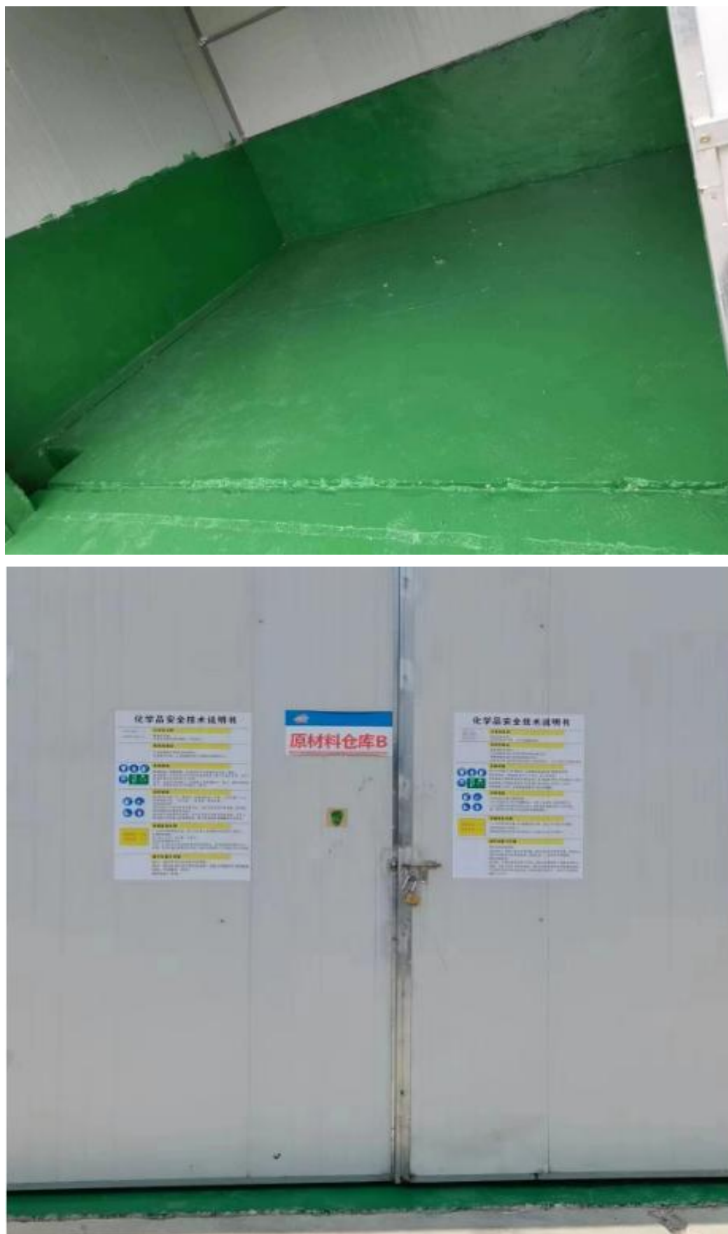
图 4.2-1 建设项目化学品仓库
