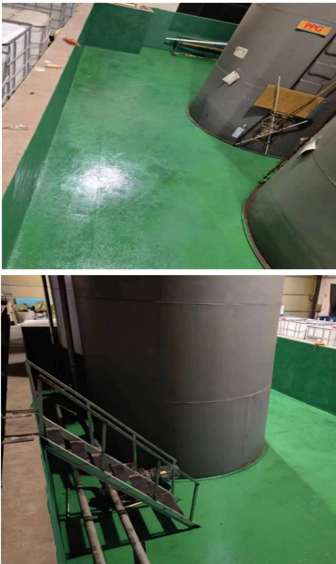
图 4.2-3 建设项目储罐区
