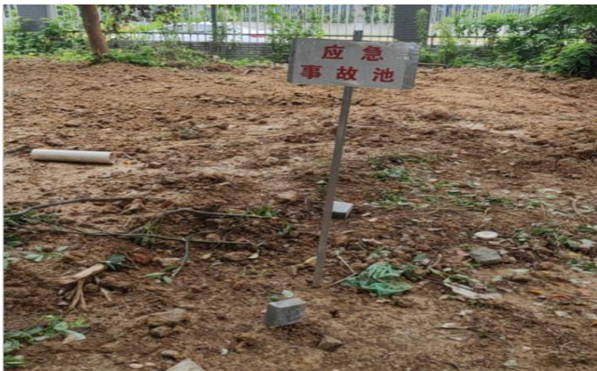
图 4.2-6 应急事故池（地下式）
