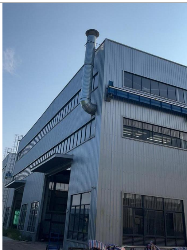
喷漆晾干废气收集措施
