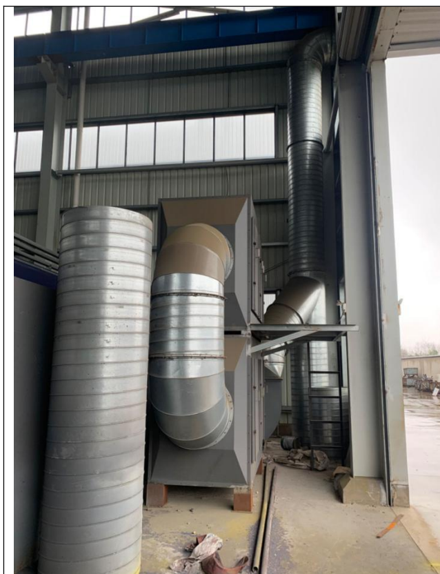
喷漆晾干废气收集措施
