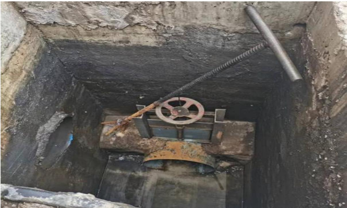
图 4.2-2 雨水排放口处的切断阀
