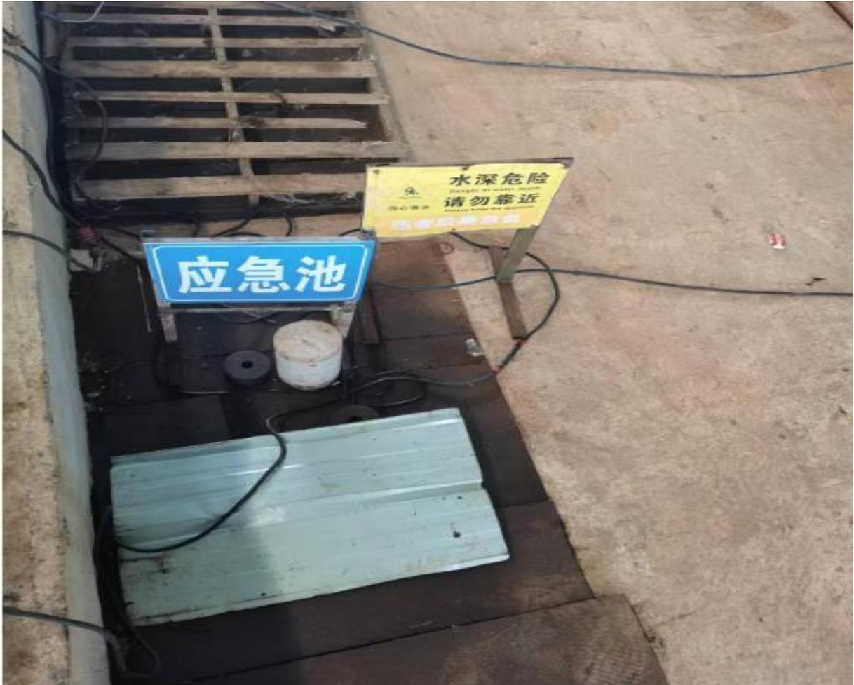
图 4.2-1 污水处理站下方的应急事故池
